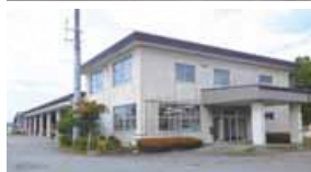
老朽化した維持管理事務所
