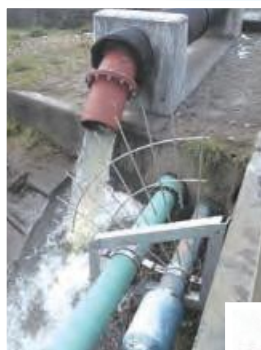
緑町冠水対策 ポンプ設置工事
