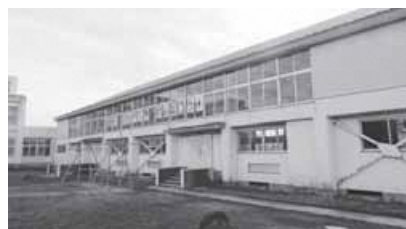
旧松浦小学校体育館
