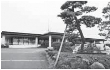
市水道局庁舎
