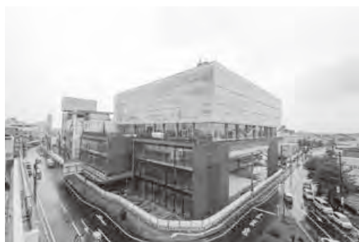
建設中の市役所新庁舎
