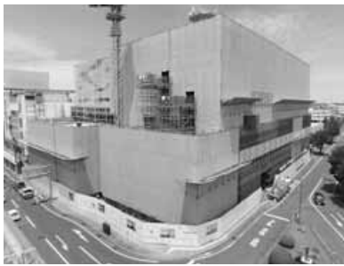
建設中の新庁舎
