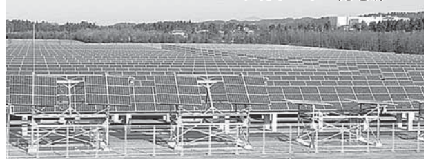
阿賀野市に県が設置したメガソーラー発電所
