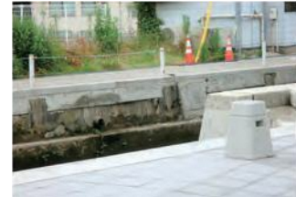
工事中の親水広場
