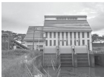
西名柄排水機場
