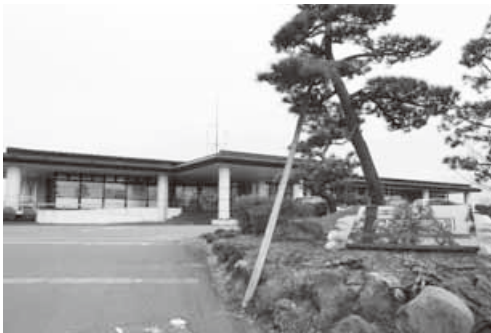
市水道局庁舎
