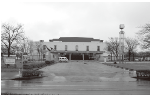
改修工事中のカルチャーセンター
