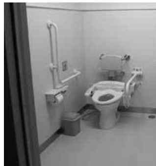
紫雲寺中学校に設置された車椅子等に対応したトイレ
